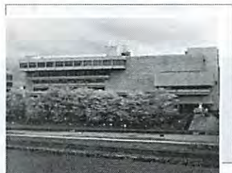
岡山衛生会館・三木記念ホール
